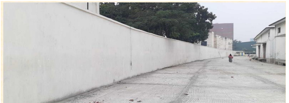
অভ্যন্তরীণ রাস্তা মেরামত কাজ (তেজগাঁও সিএসডি, ঢাকা)
